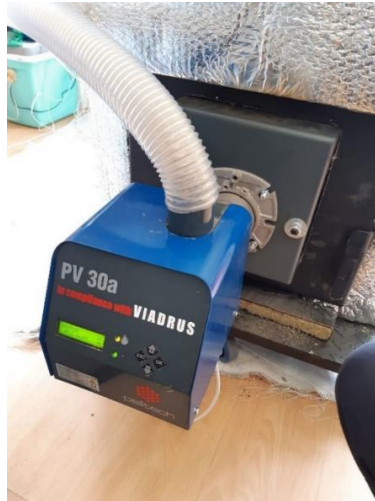
Слика 3.31. Горионик за пелет – Pelltech PV 30a – снаге од 15 до 30 kW
