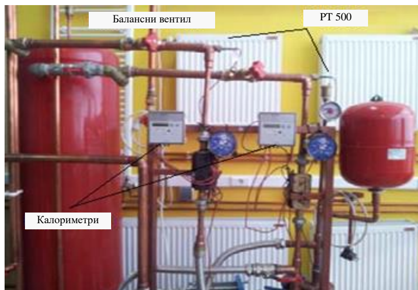
Слика 3.43. Калориметри и PT – 500 сонде, са баланским вентилима HERZ Stromax
