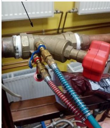
Слика 3.49. Прикључци диференцијалног манометра на балансном вентилу
