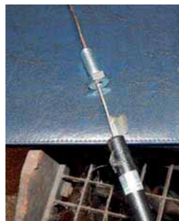
Slika 6.6 - Izvođenje vijka za bezbedno postavljanje mernih sondi
