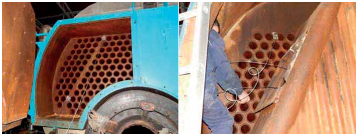
Slika 6.8 - Postavljanje temperaturskih sondi
