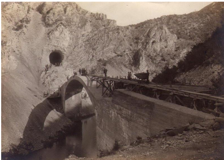
Друга фаза радова на изградњи железничког моста од армираног бетона у Сврљишкој клисури
