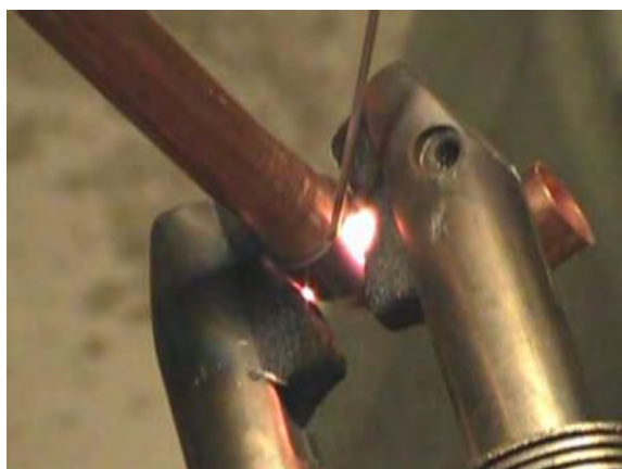
Slika 8.6 Postupak ručnog elektrootpornog visokotemperaturnog lemljenja bakarnih cevi [18]
