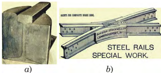
Slika 6.18 Železničko skretničko srce zavarjeno postupkom livačkog zavarivanja, a – poprečni presek šine, b – skretničko (tramvajsko) srce, slikano 1885 i retuširano radi štampe u časopisu „The Street Railway Journal“ [19]
