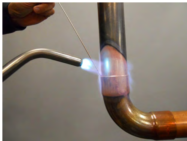
Slika 8.3 Postupak tvrdog lemljenja bakarnih cevi plamenom [13]
